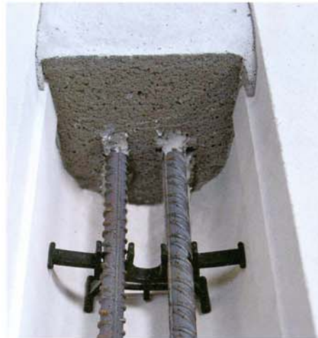
Die guten Brandschutzeigenschaften liegen darin begründet, dass der Betonkern und die Bewehrung an drei Seiten von KS-Schalen geschützt werden.
